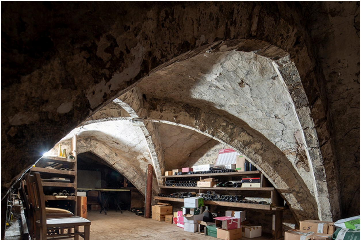
Cave du bâtiment sur rue. Croisée d'ogives (travée centrale).
