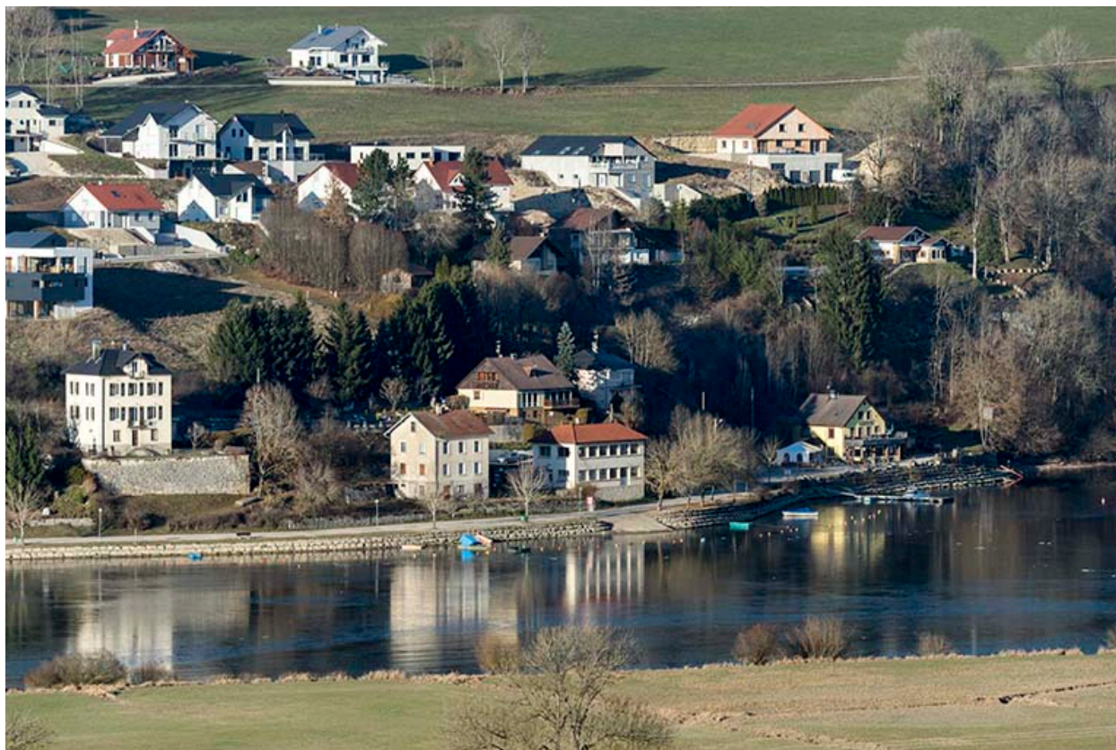
Le port de Chailleux.
