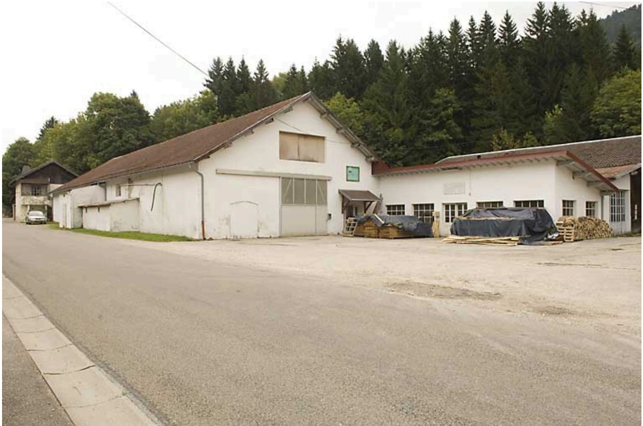
Partie nord du site : vue générale.
