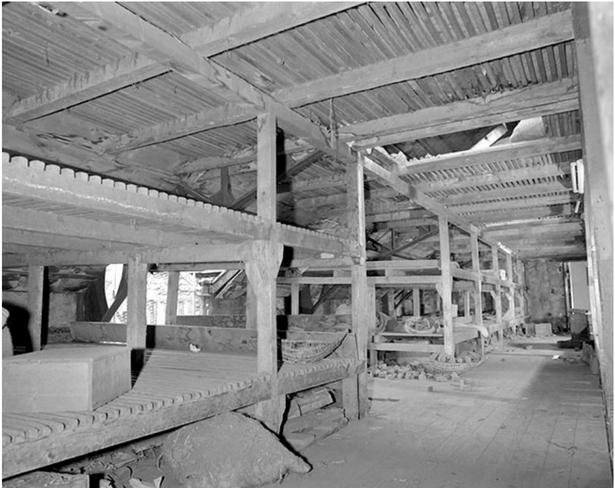
Intérieur d'un séchoir à ébauchons (bâtiment nord).
