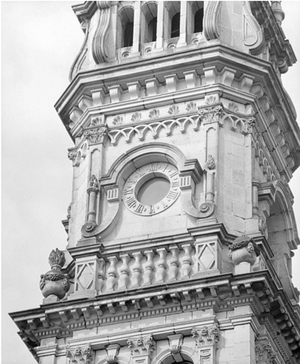
Quatrième niveau de la tour nord.
