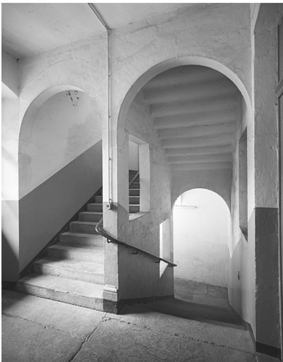
Bâtiment rue de la Poyat : escalier.
