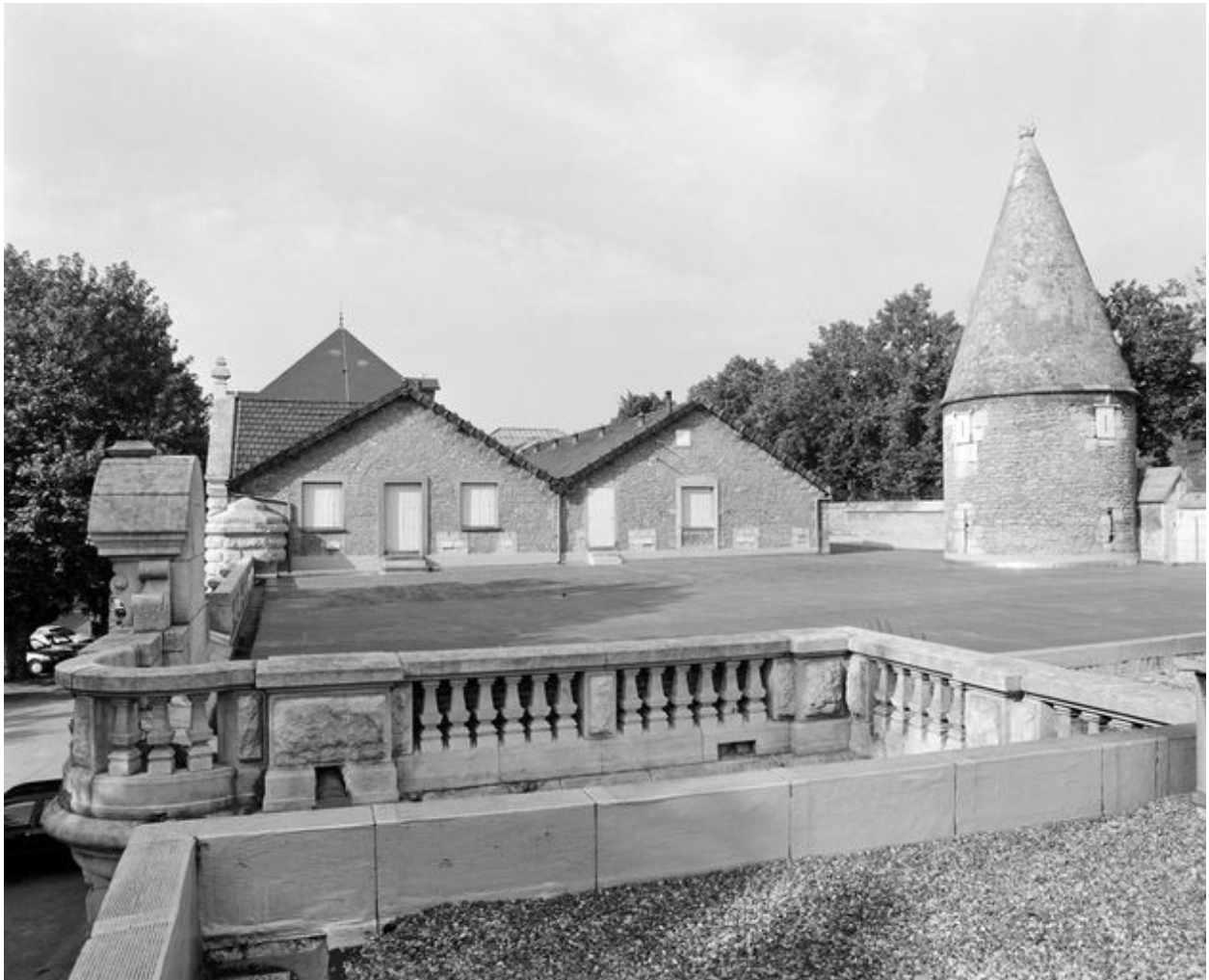
Tour des Poudres, partie supérieure depuis la terrasse du magasin Calvet.
