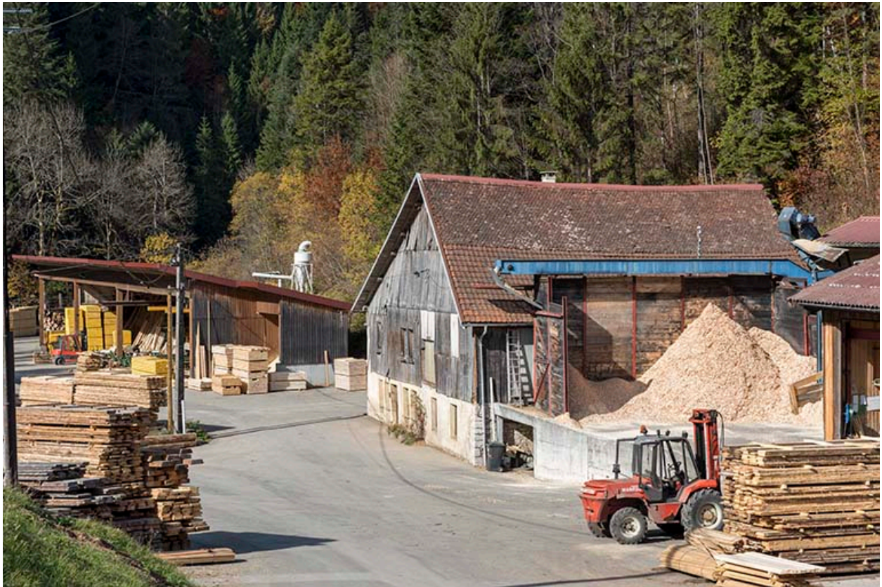
Ancienne scierie et ateliers à l'ouest.
