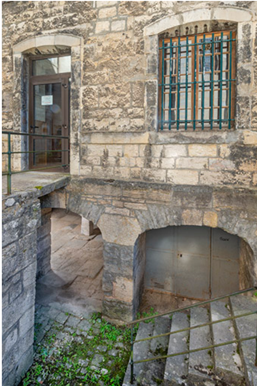
Escalier d'accès aux cellules, depuis la cour ouest.
