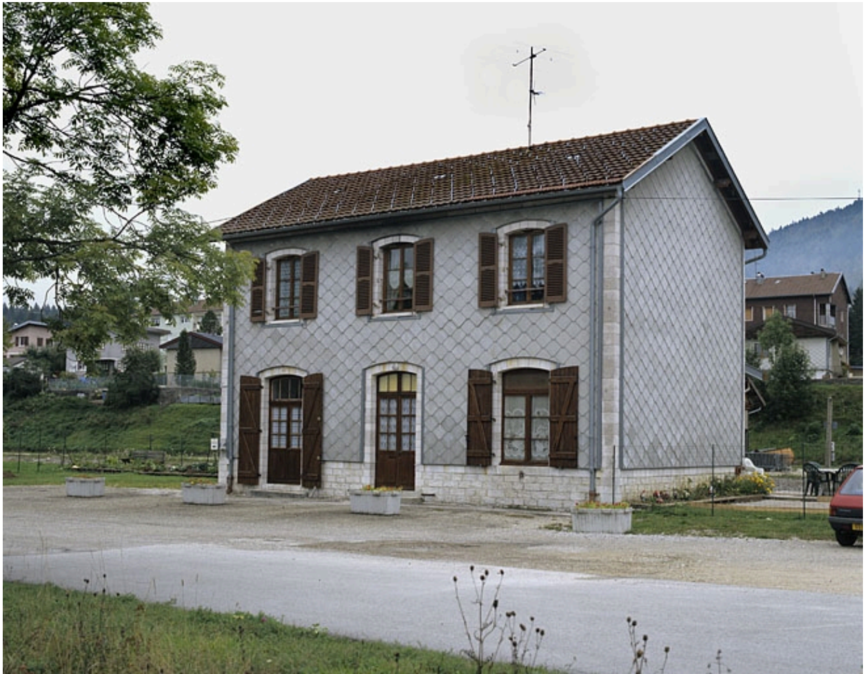
Bâtiment des voyageurs : élévation antérieure, de trois quarts droite.
