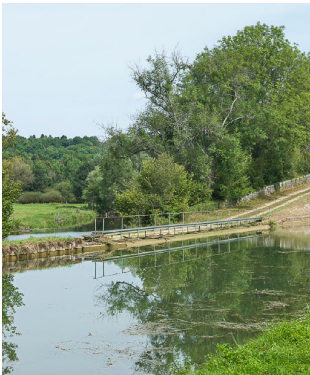
Vue du déversoir.
