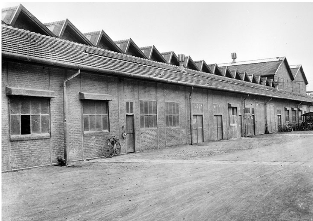
Façade des ateliers de réparation (ATM).
