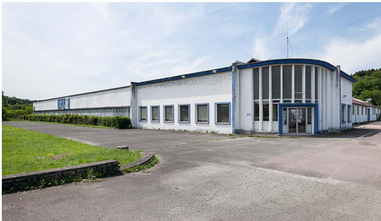
Façade est et entrée de l'usine.
