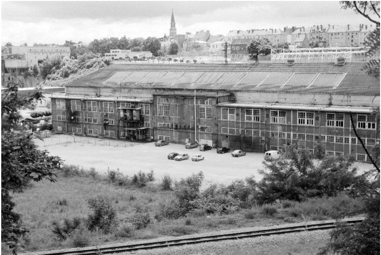
La salle des machines de l'ancienne station centrale vue du nord-ouest.
