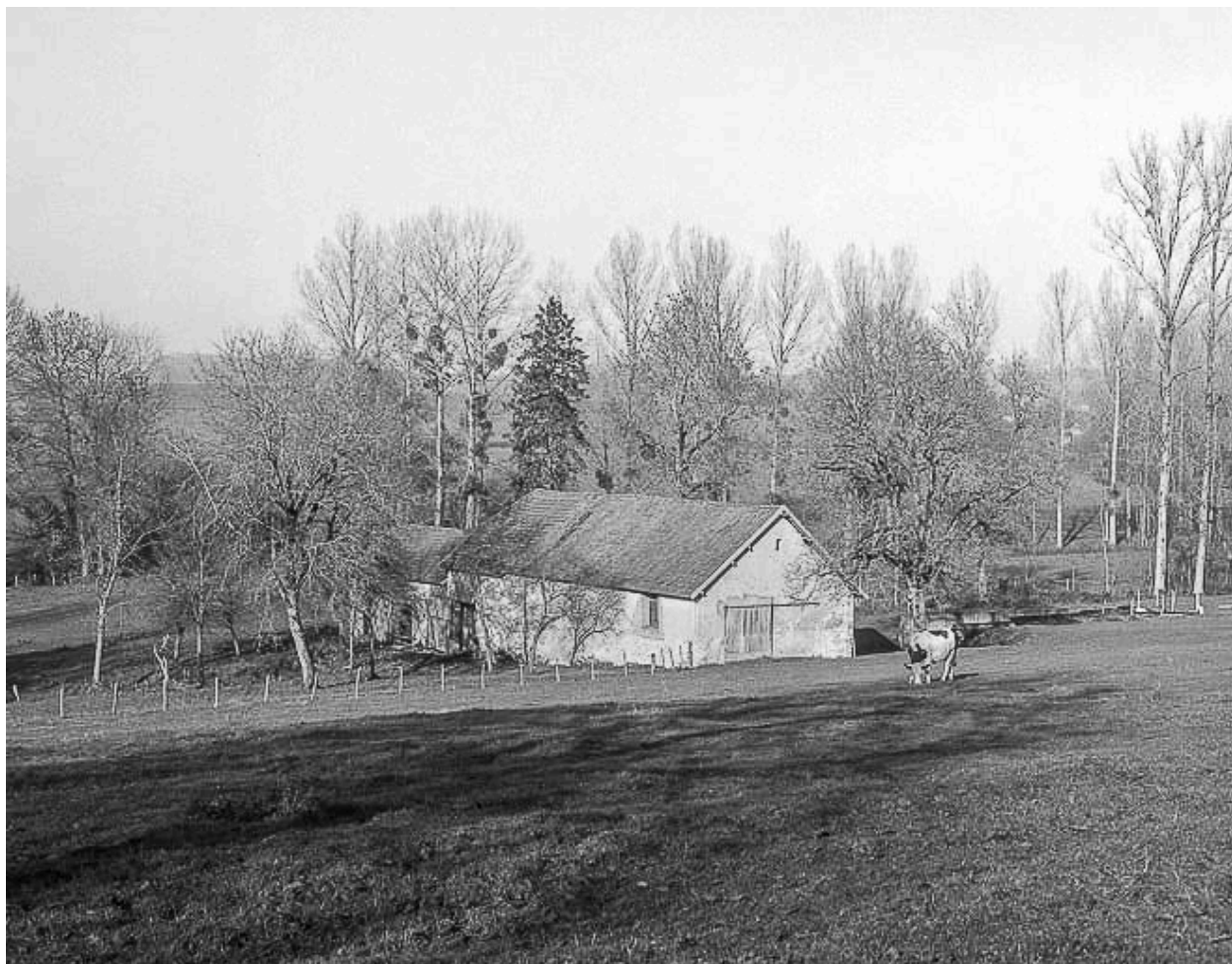
Vue d'ensemble éloignée du revers des bâtiments.
