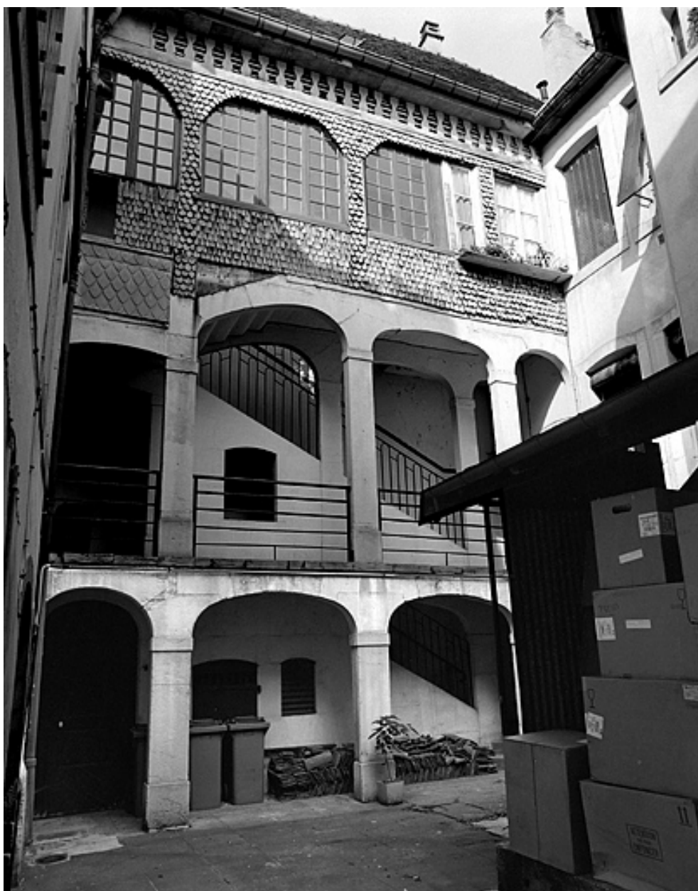
Escalier dans la cour, vue d'ensemble.
