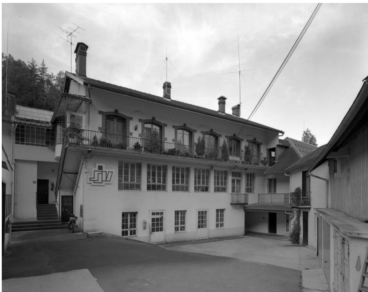
Façade sur cour du bâtiment de 1902.
