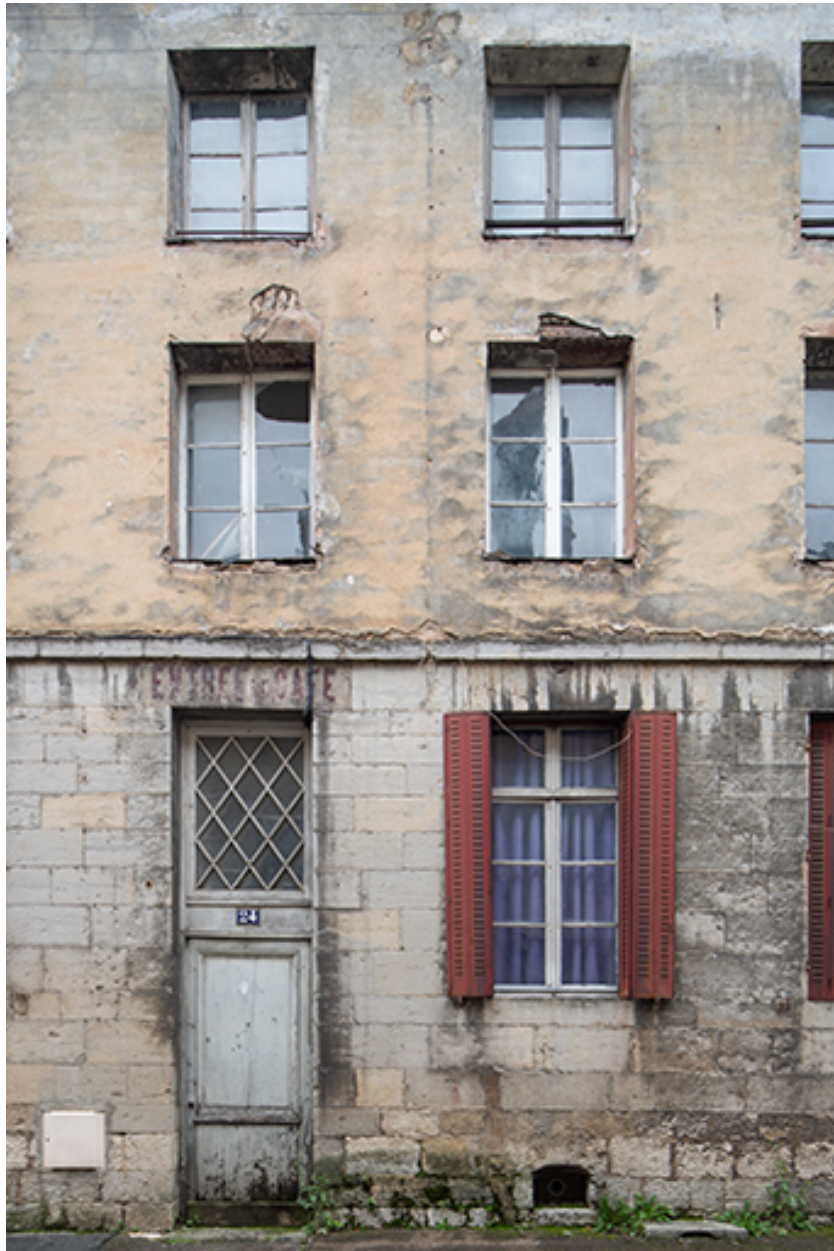
Travées centrales de la façade postérieure.
