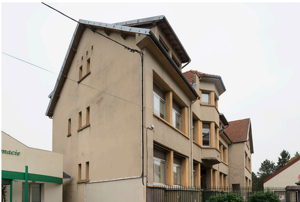
Bâtiment d'entrée vu de trois quarts.
