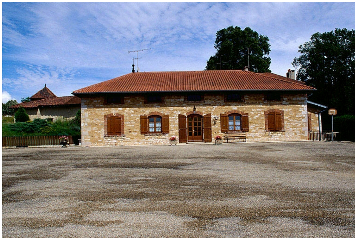
Usine de taille de matériaux de construction du moulin Antides, à Saint-Amour : scierie.
