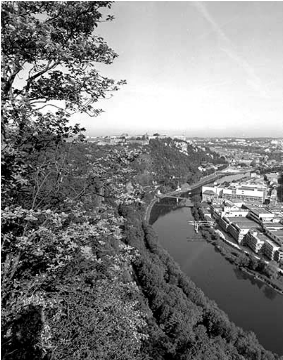
Vue panoramique partielle depuis le sud : 1er volet (gauche).
