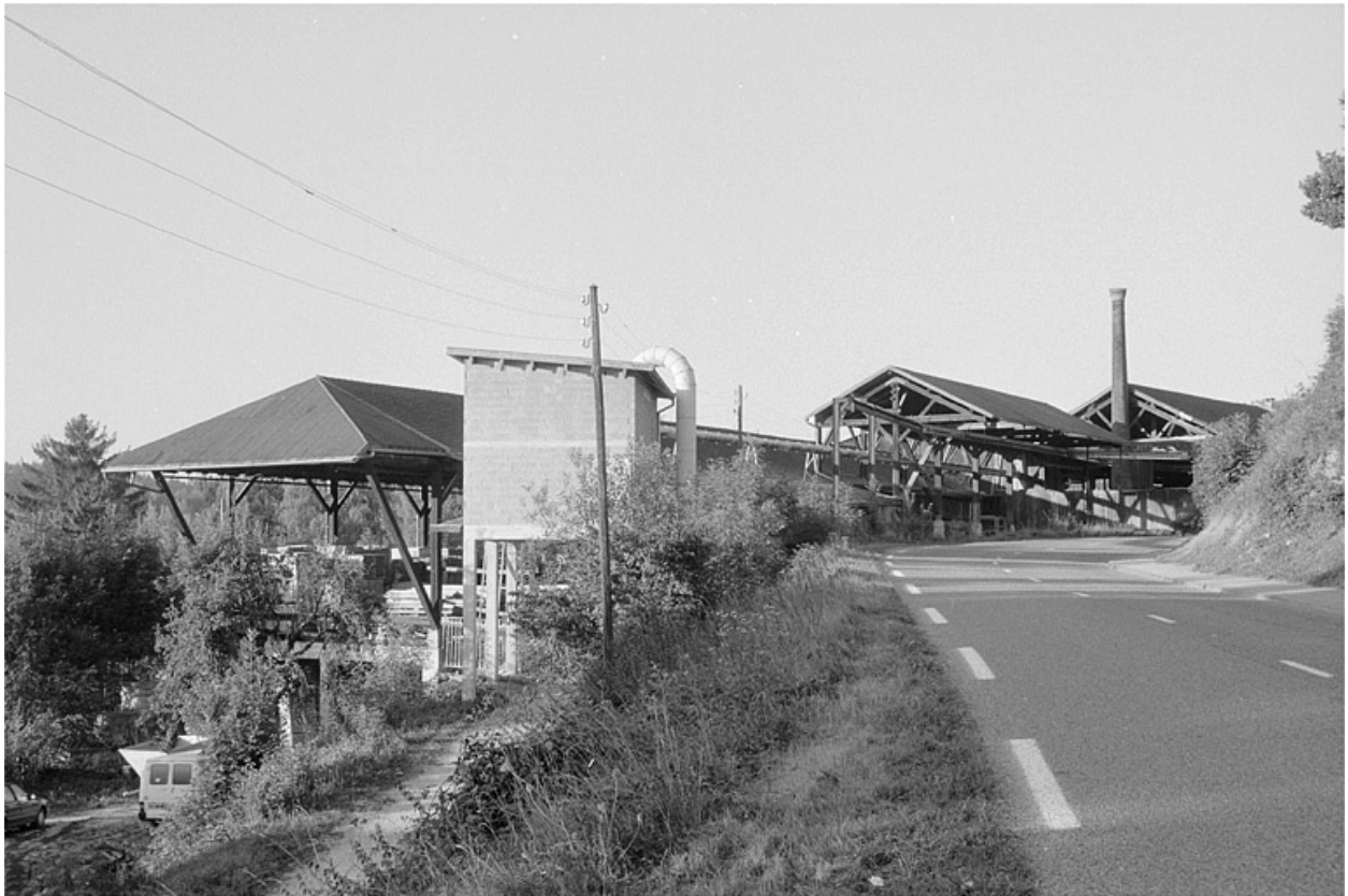
Usine de tournerie et scierie Janier-Vuillermoz, Lavans-lès-Saint-Claude (2-4 rue du Caton).
