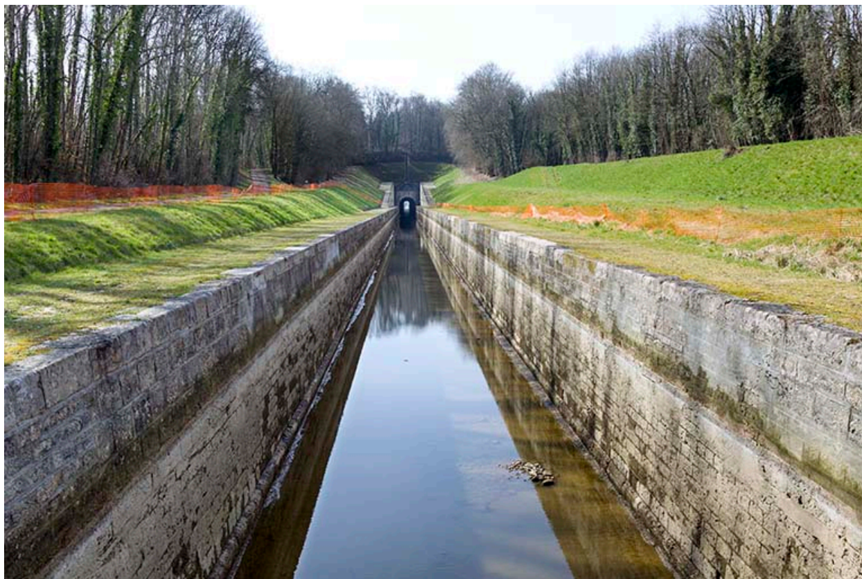
Le canal de navigation et le souterrain de Savoyeux.
