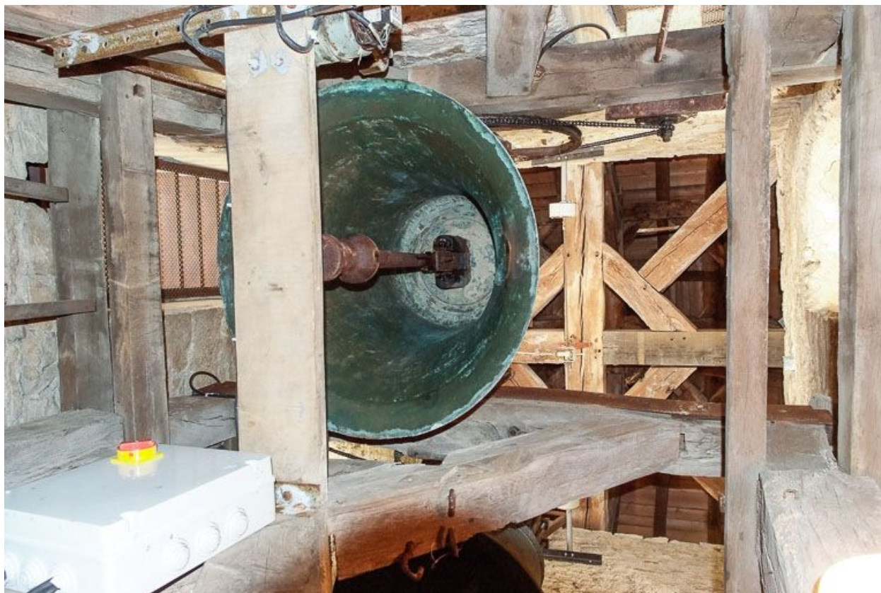
Vue depuis le plancher du clocher.
