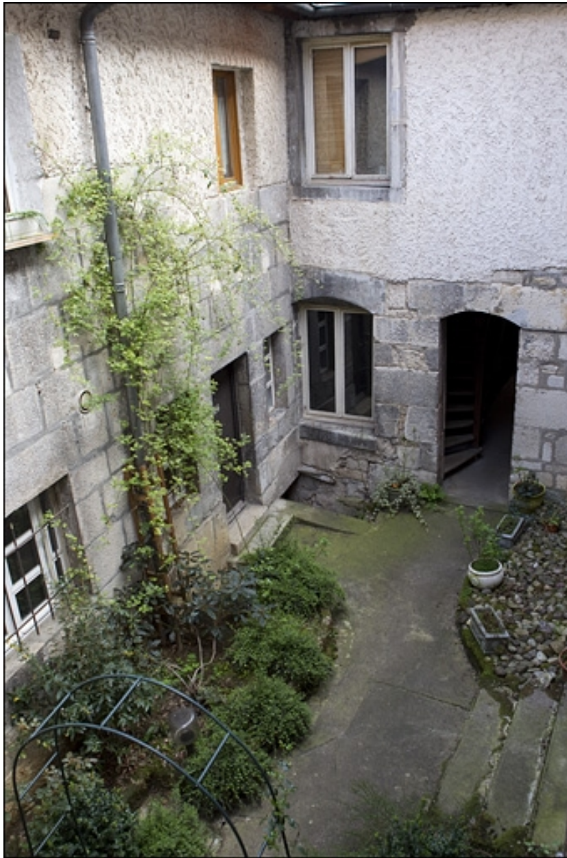
Vue d'ensemble des façades du logis secondaire depuis l'escalier dans la deuxième cour.
