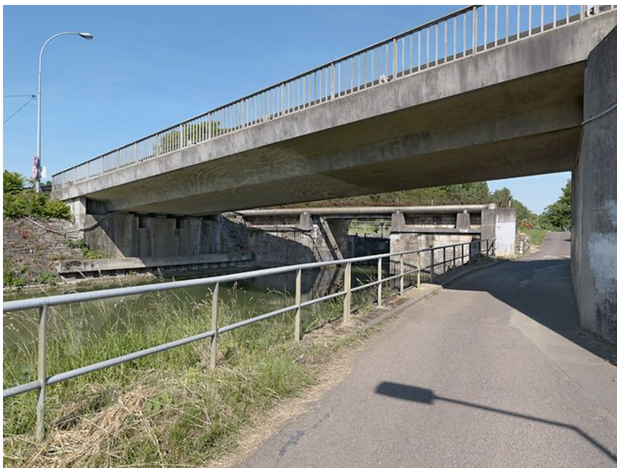
Pont moderne remplaçant le pont sur l'écluse 56.
