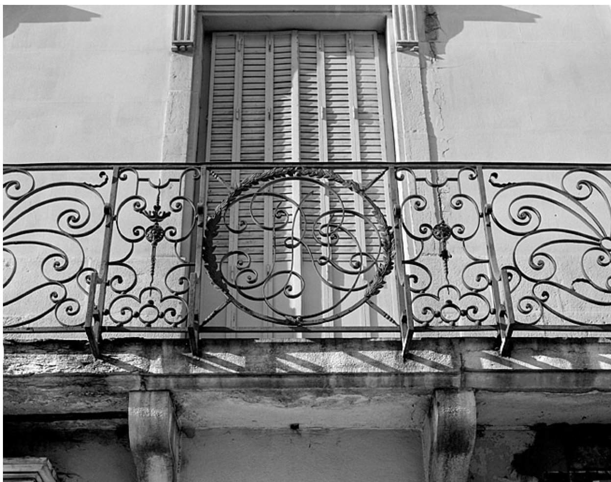
Façade antérieure, détail du balcon.
