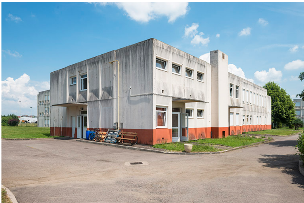
Angle sud-ouest de la restauration.
