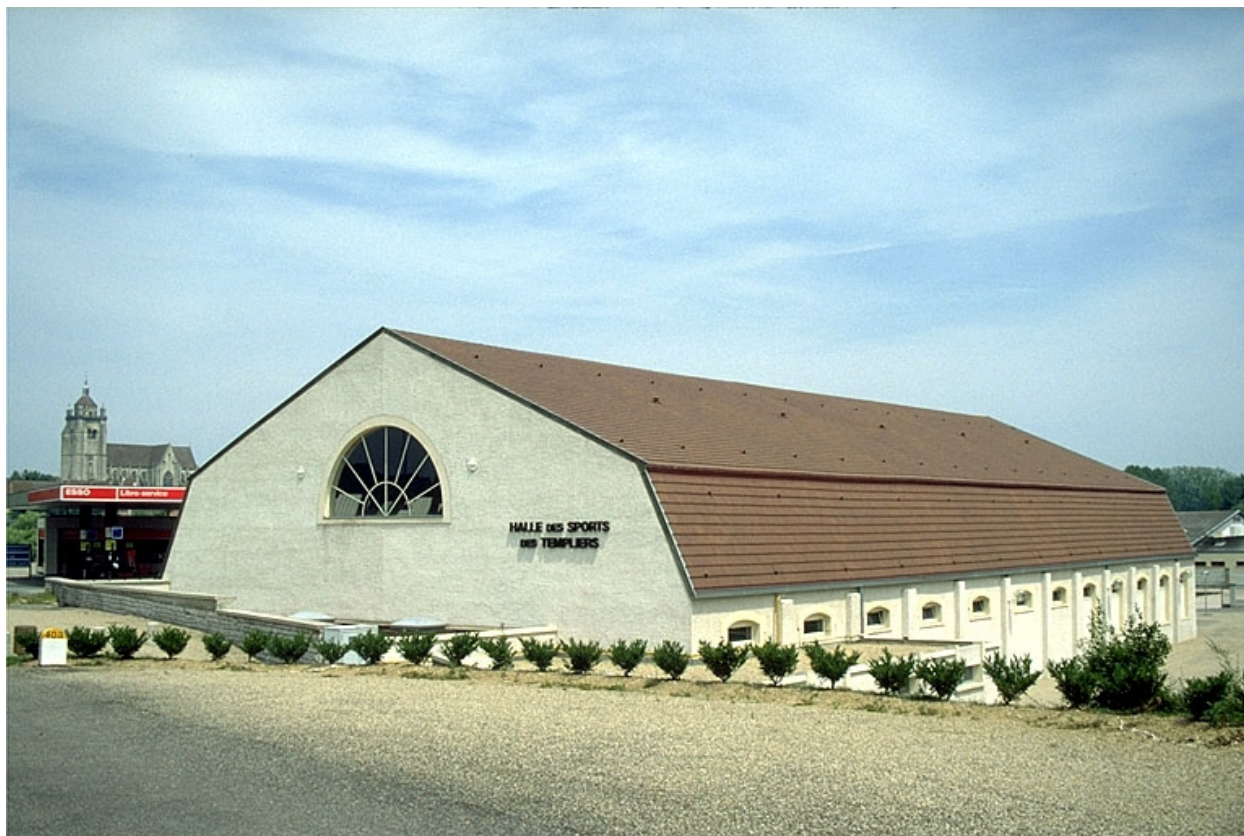
Vue d'ensemble du gymnase, depuis le sud-ouest.
