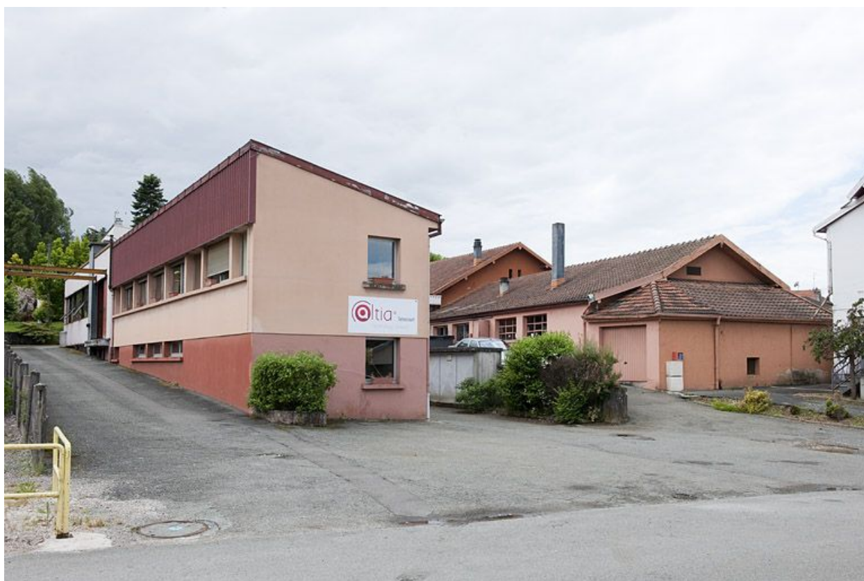
Vue d'ensemble depuis la rue.
