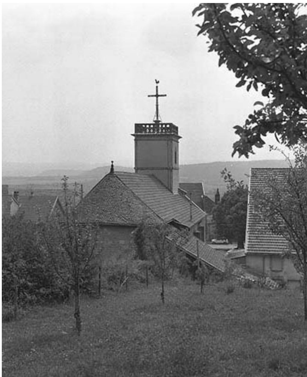
Extérieur : abside, vue de trois quarts.
