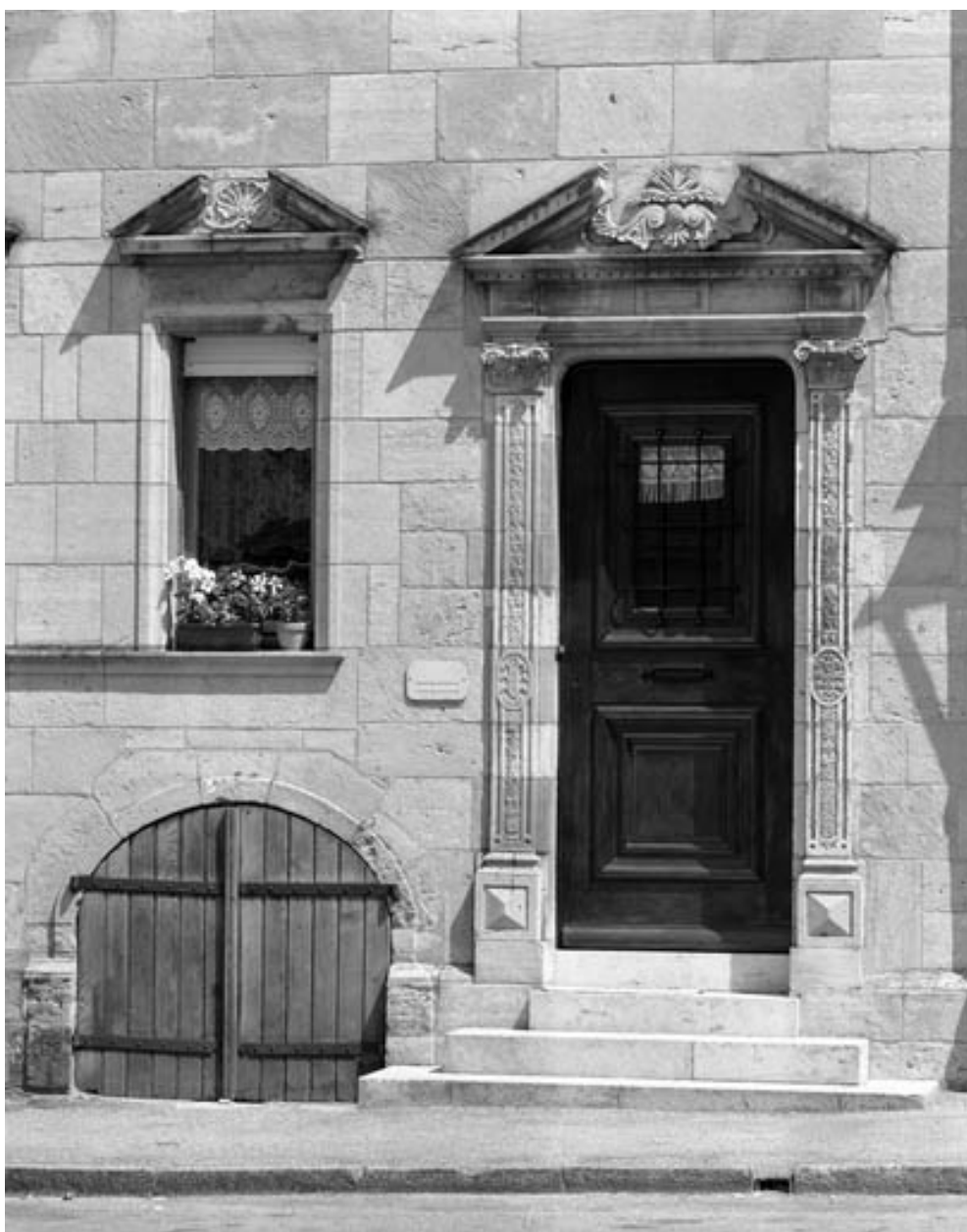
Façade antérieure : détail porte d'entrée sur rue.
