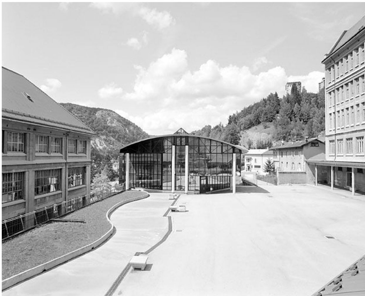
Cour, terrasse du bâtiment E et bâtiment F.
