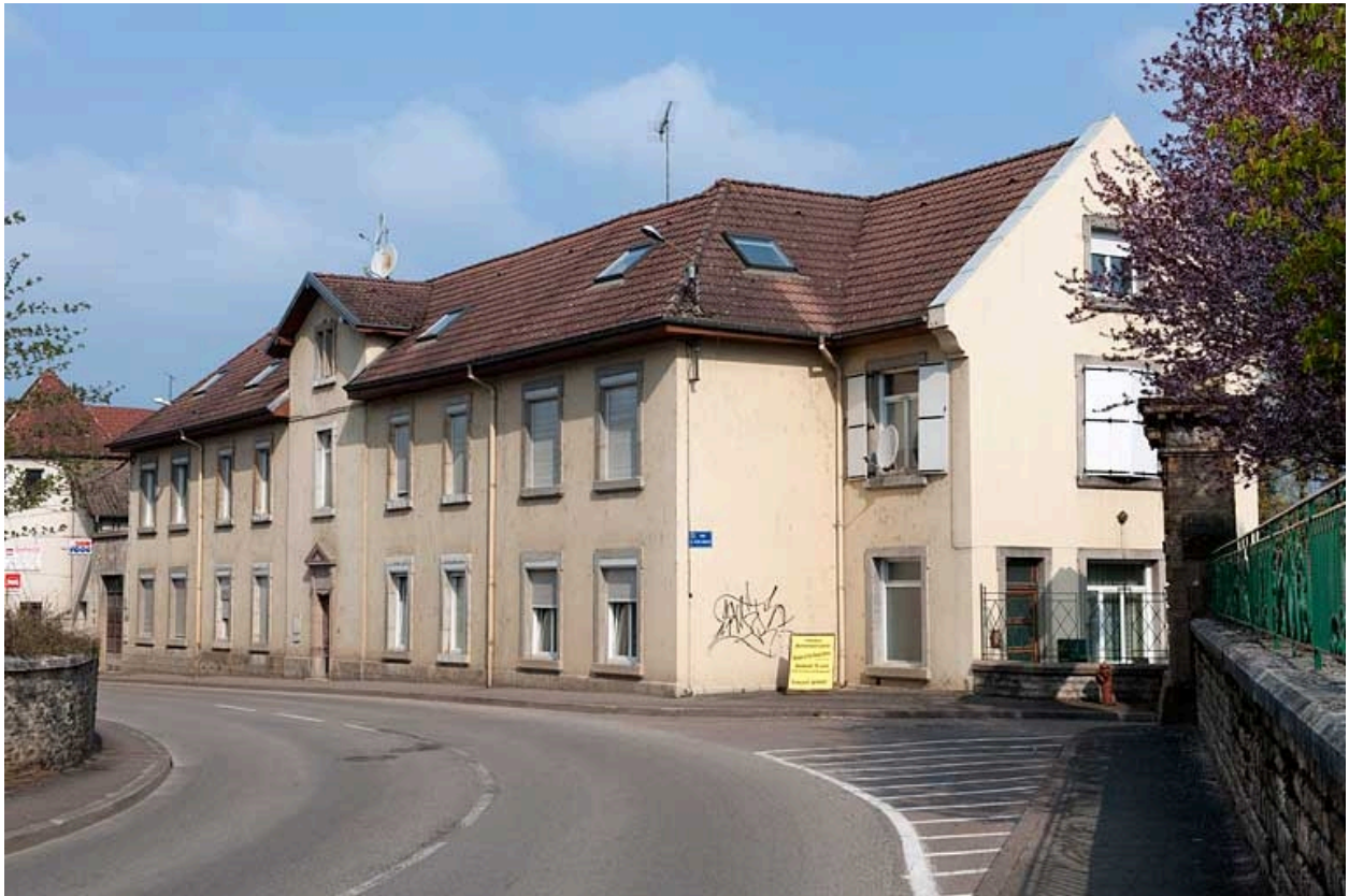
Vue générale de l'ancien pavillon d'isolement.
