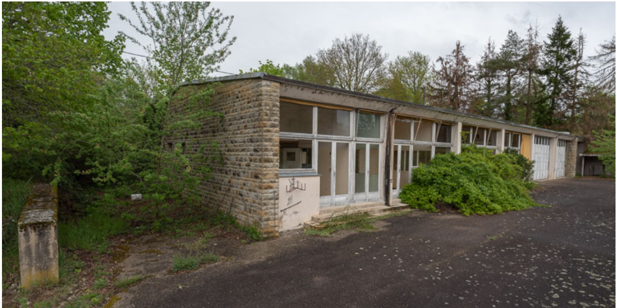
Bâtiment des garages et des ateliers.
