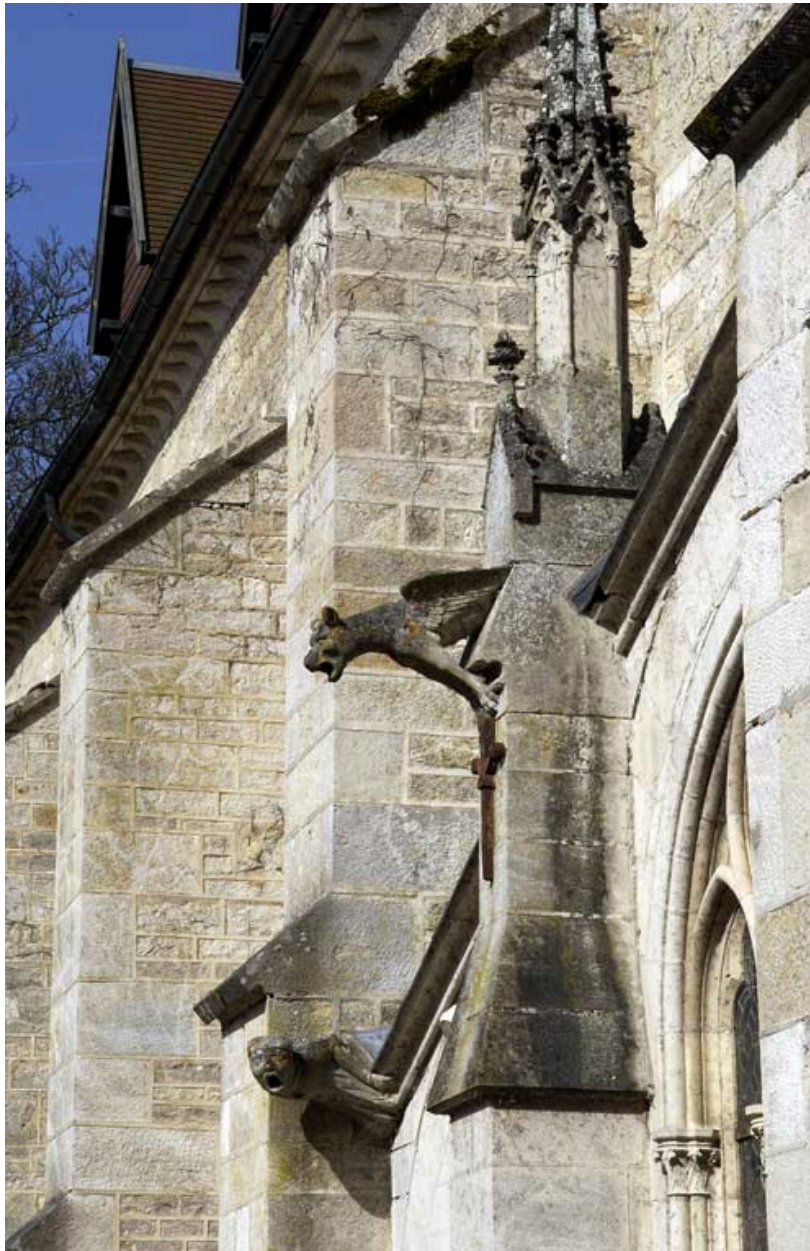
Bâtiment du réfectoire : élévation ouest, gargouilles néo-gothiques.
