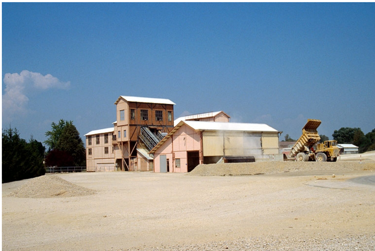
Bâtiments du broyeur vus du sud-ouest.
