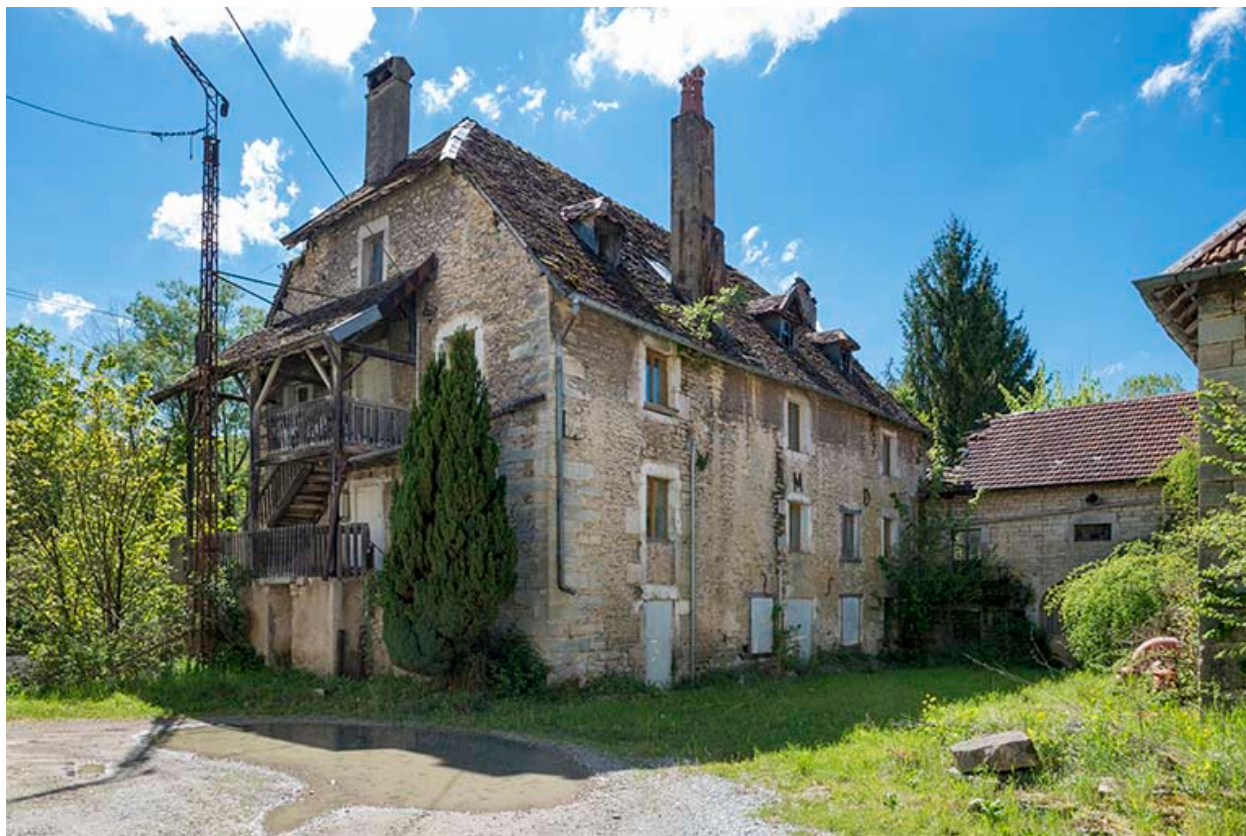
Bâtiment du moulin (puis logement ouvrier).
