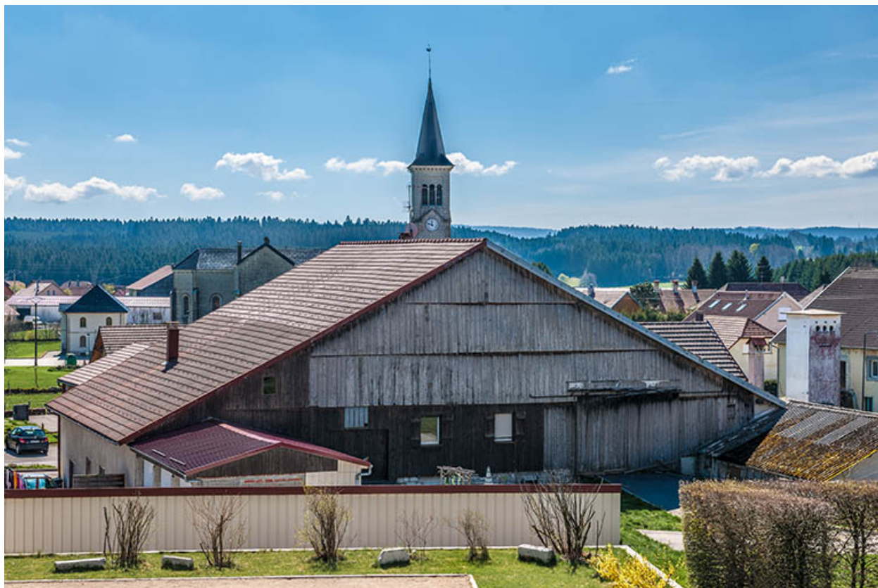
Ferme : façade postérieure.
