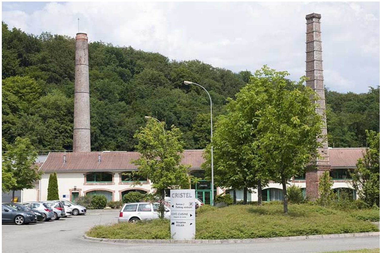
L'usine depuis l'entrée du site.
