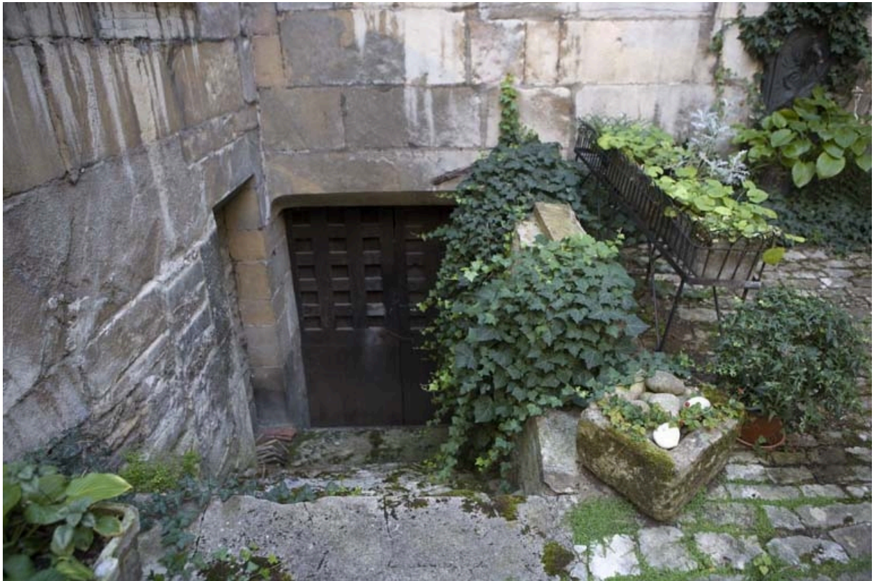
Façade postérieure du logis : entrée de cave.
