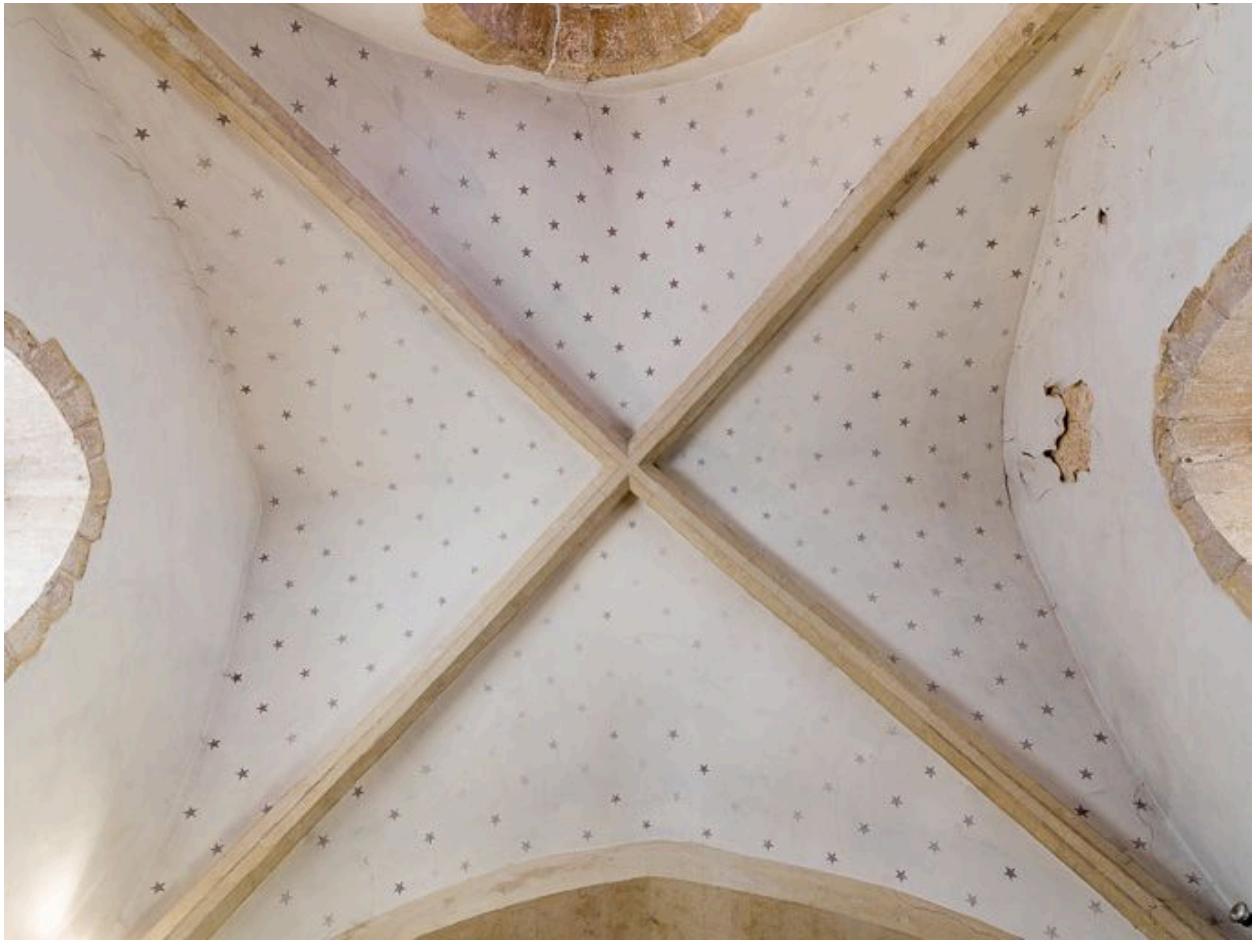
Voûte du chœur.
