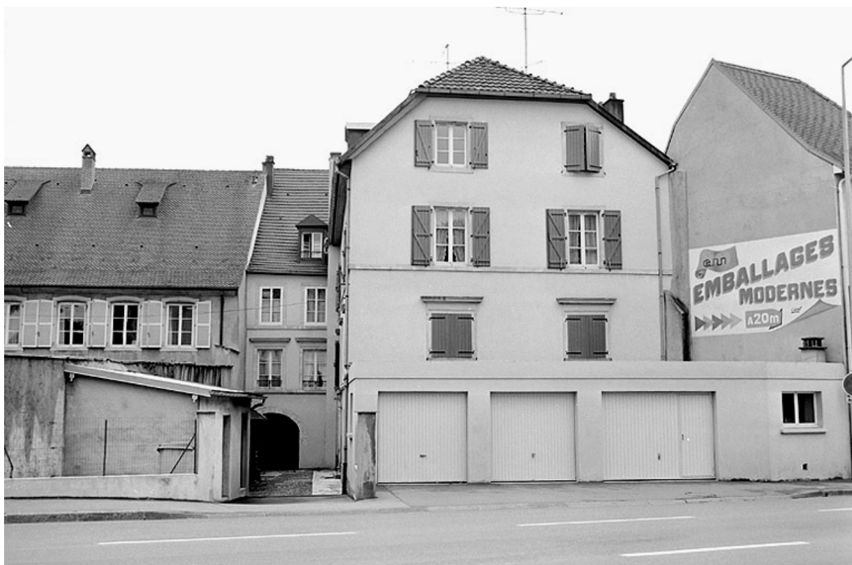
Vue d'ensemble depuis le boulevard périphérique.
