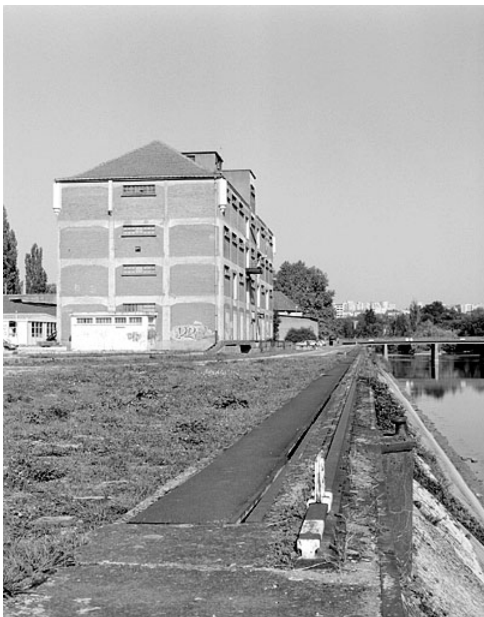
Entrepôt et quai, depuis l'amont (vue rapprochée)
