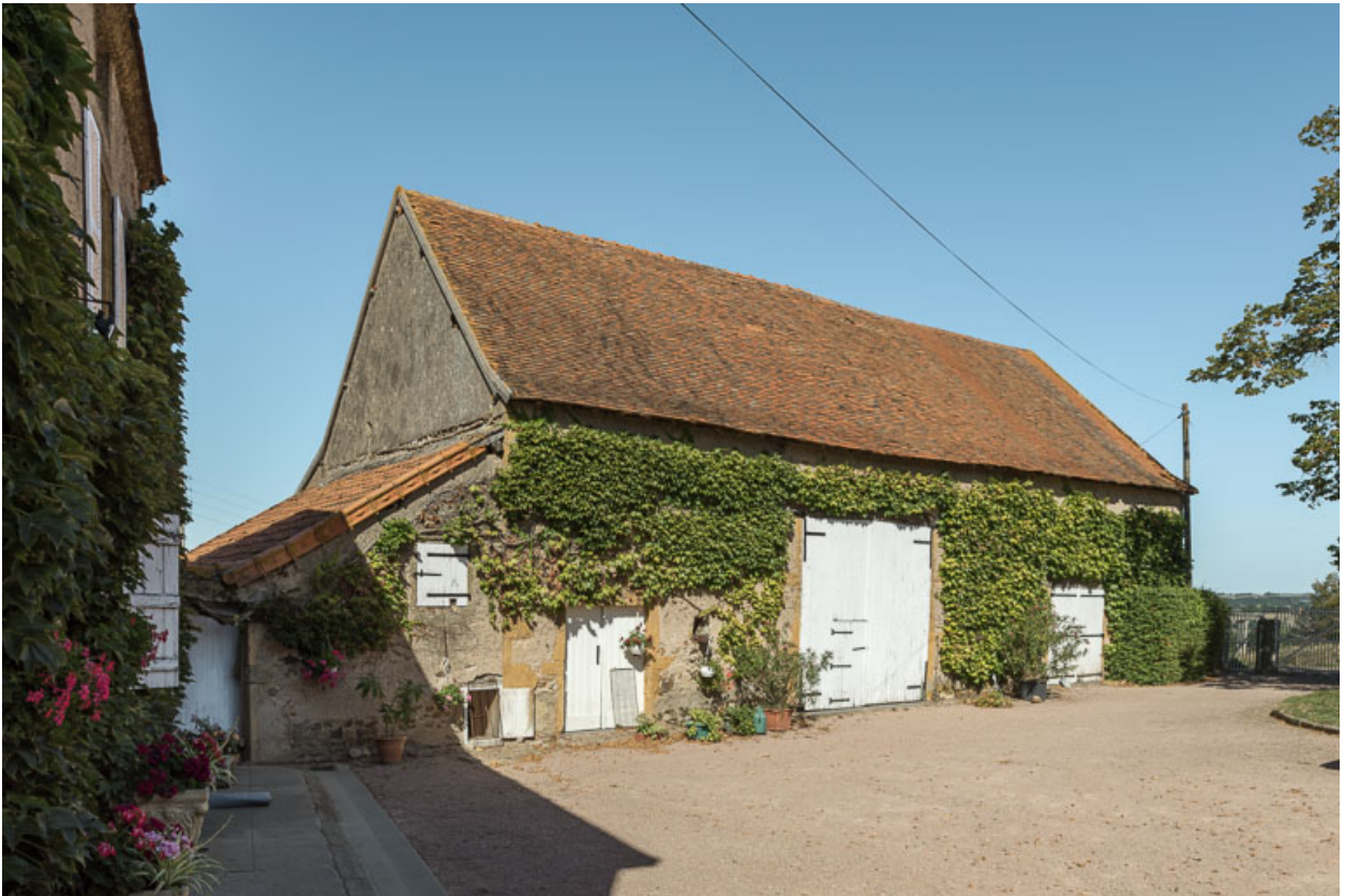
Façade antérieure de la grange
