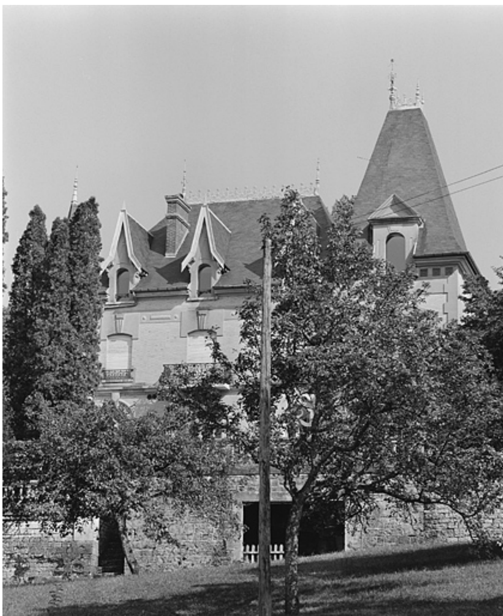
Façade antérieure, vue générale.
