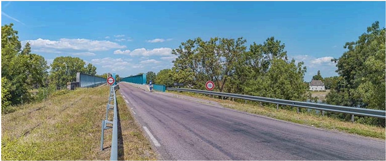
Vue d'ensemble des deux voies du pont.
