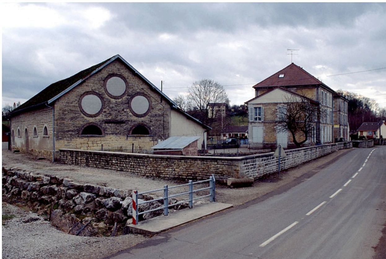
Saline de Grozon : bâtiments de la machine d'extraction à gauche, des bureaux et logements à droite.
