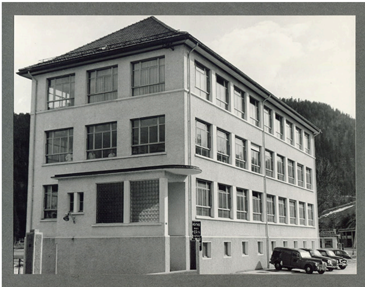
Façades antérieure et latérale gauche, années 1960.
