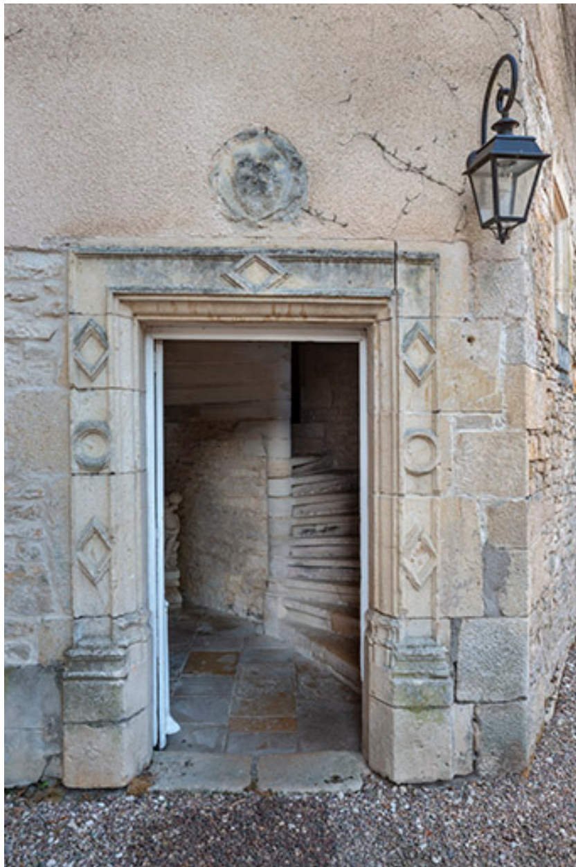
Encadrement de la porte de la tour d'escalier (porte ouverte).
